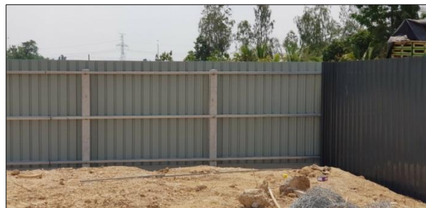
รูปที่ 4.1.5-5 ตัวอย่างรั้วชั่วคราว (Aluminum Sheet)
