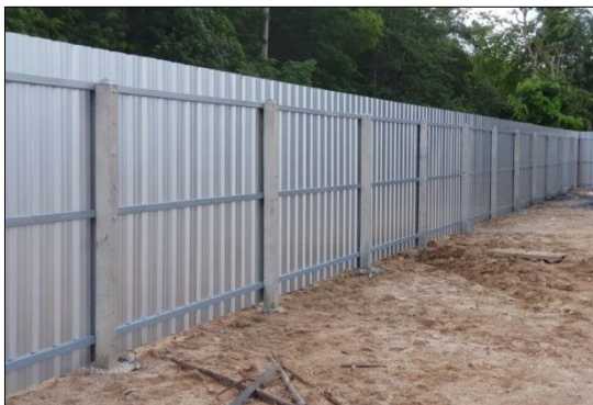
รูปที่ 4.1.5-5 ตัวอย่างรั้วชั่วคราว (Aluminum Sheet)
